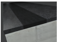
Nahtlos fügt sich der Übergang in die Strassen und Parkdeckoberflächen ein
