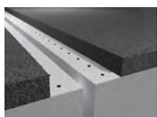
*Fugenmulde wird sorgfältig ausgebrochen und sandgestrahlt oder im Beton ausgespart.*
