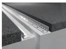
*Die Stahlelemente der Verteilkonstruktion massgenau eingebaut.*
