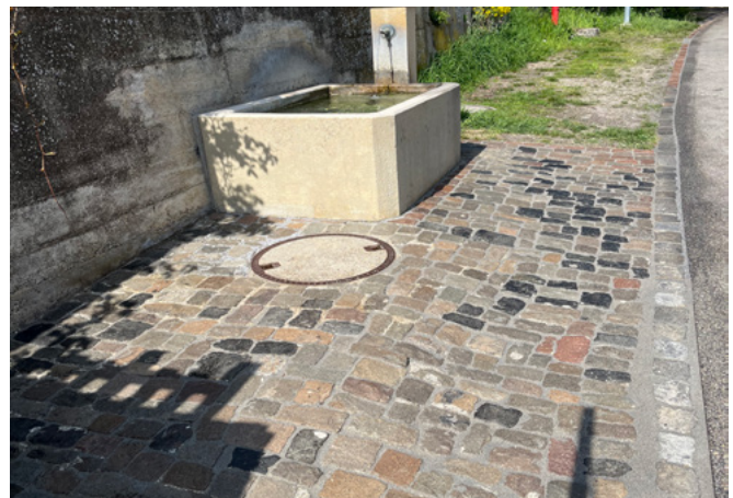
Fugenbild nach der Sanierung durch RSAG
