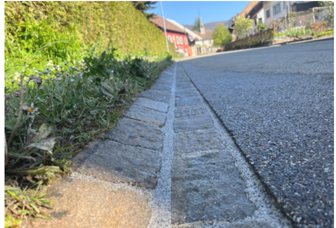
Fugenbild nach der Sanierung durch RSAG
