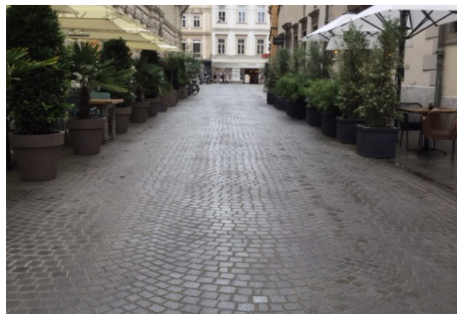
Kehrsaugmaschinen- und hochdruckreinigerfeste Fugen
