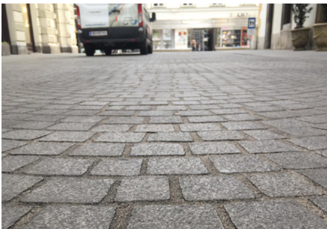
austropox® - Fugenbild nach mehreren Jahren
