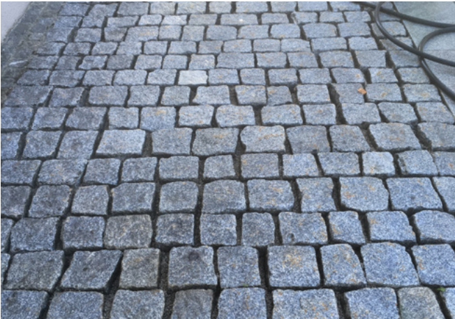
Fugenbild nach der Reinigung und vor der Sanierung
