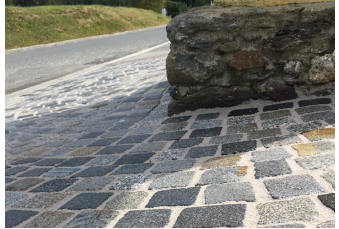
Gepflegter Fugenverschluss - unkrautfrei und pflegeleicht
