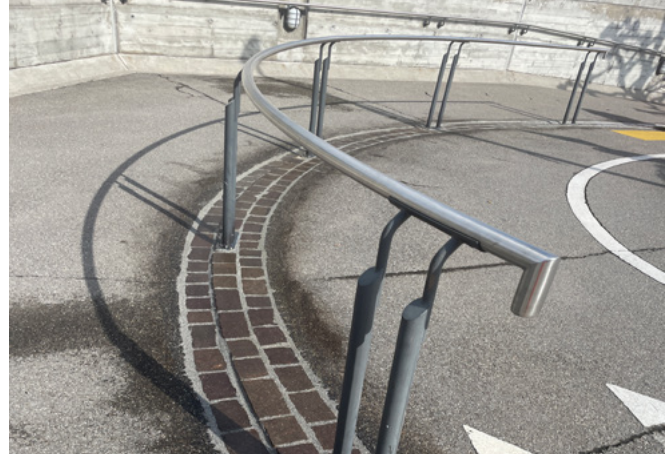
Dauerhafter und sanierter Fugenverschluss
