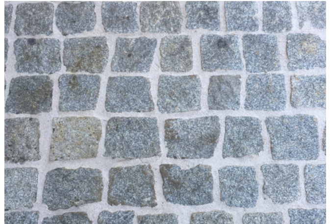
Fugenbild nach der Sanierung mit austropox®
