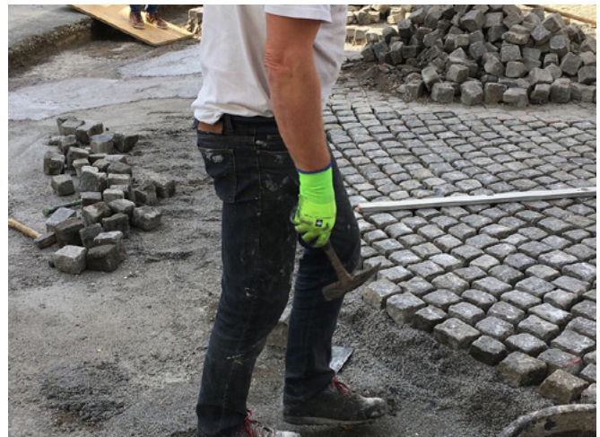
Schnellstaushärtende Instandsetzungen und Sanierungen
