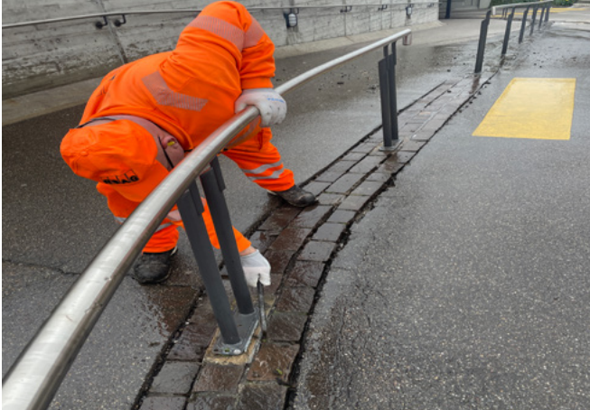
Reinigung des Altbestandes und Entfernen des Unrats
