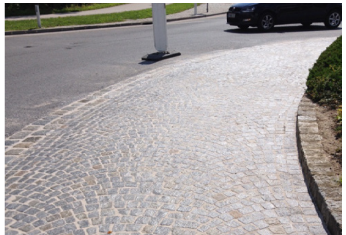
Kreisverkehrssanierung unter laufendem Betrieb
